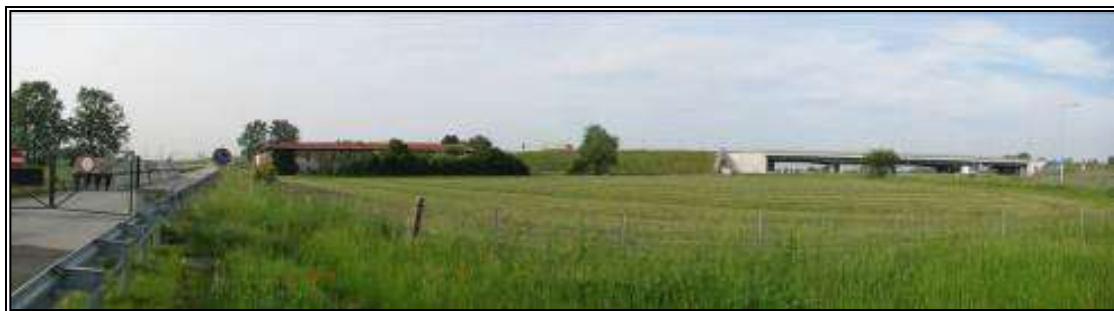
Foto 2 - Area: "Cascina Malastalla" e cavalcavia SS 336
